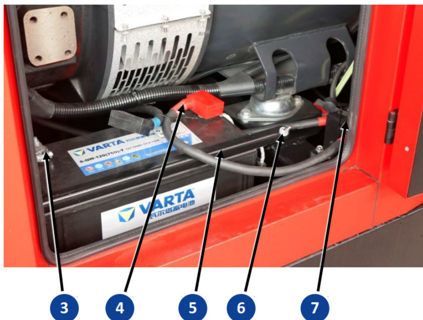
Abb. 10-1 Starterbatterie (Abbildung ähnlich)
